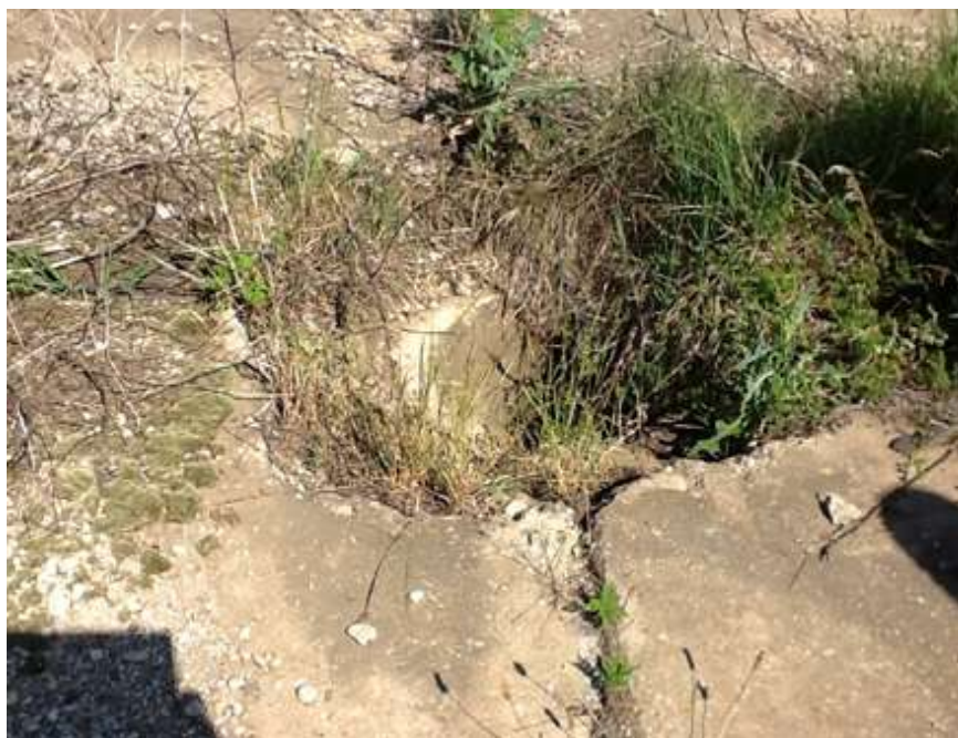
Figura nr. 17 – Imagine canal pluvial
